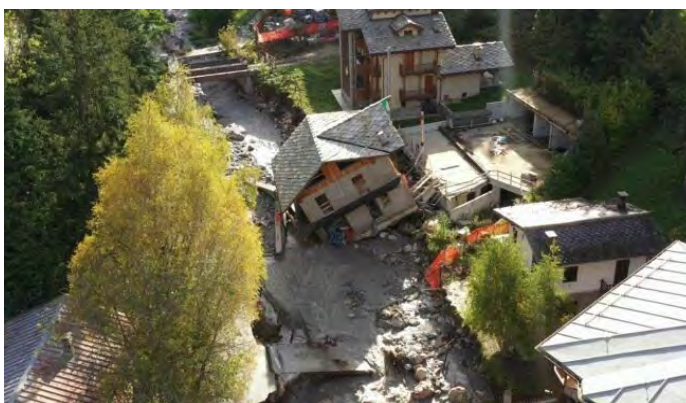
La foto ripresa da un drone ci mostra una casa finita direttamente nel torrente Vermeagna, neanche fosse fatta di cartone.
